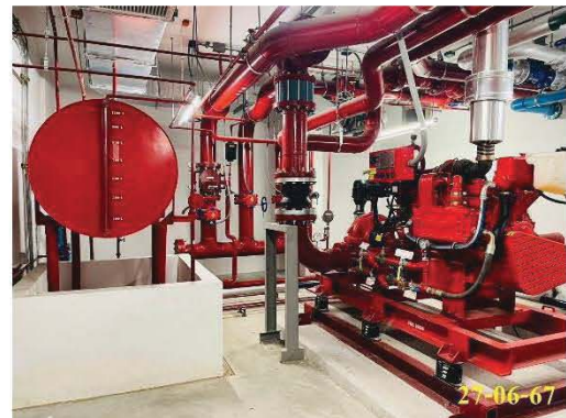
ระบบสูบน้ำดับเพลิง
